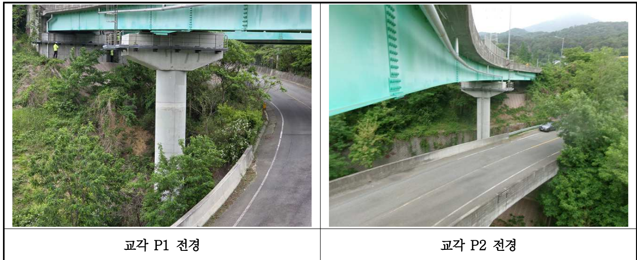
【사진 21.3.10】 교각 전경
