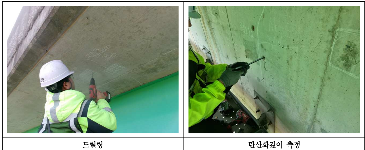
【사진 21.4.3】 탄산화 깊이 측정 현장사진
