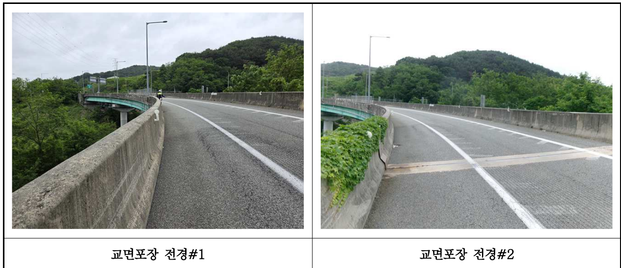
【사진 21.3.20】 교면포장 전경
