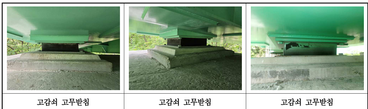
【사진 21.3.13】 교량받침 전경
