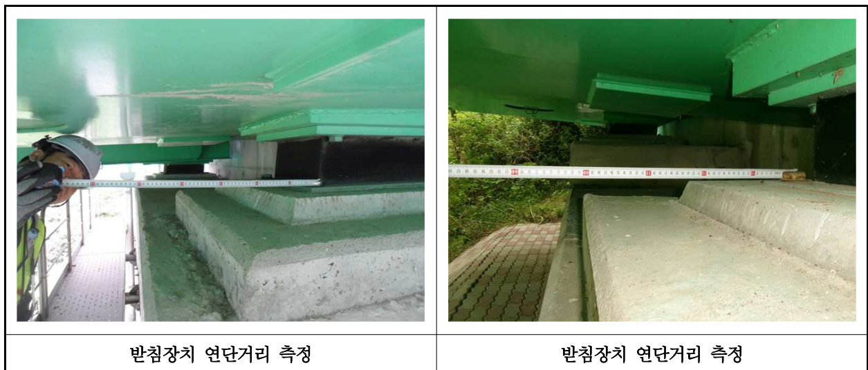
【사진 21.3.15】 교량받침장치 연단거리측정
