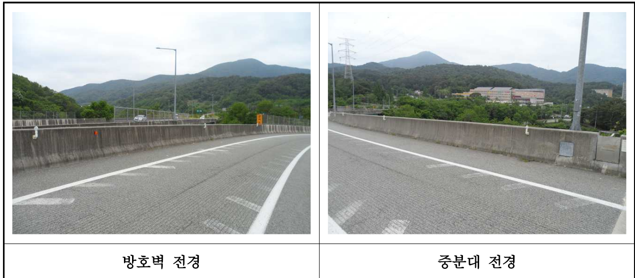
【사진 21.3.24】 방호벽 및 중분대 전경
